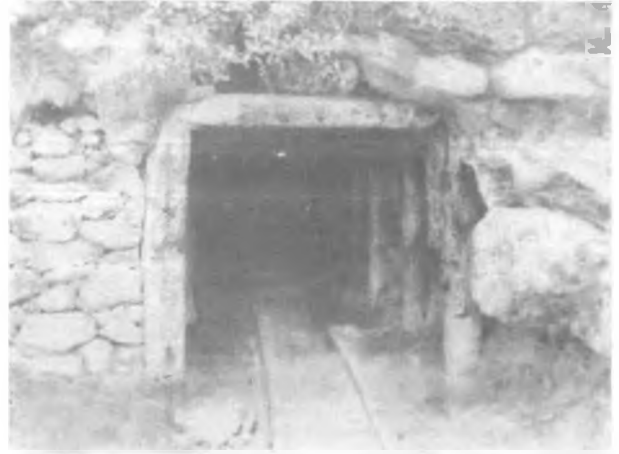
2 - Ingresso di una galleria
