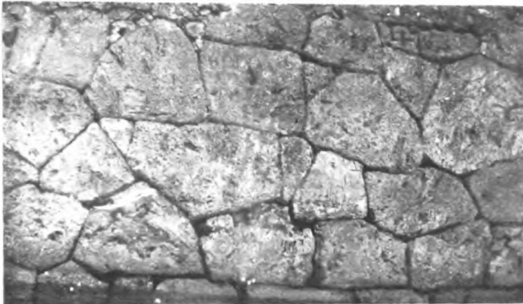
Fig. 1 — Tratto sul lato Sud-Est delle mura poligonali di Orbetello
