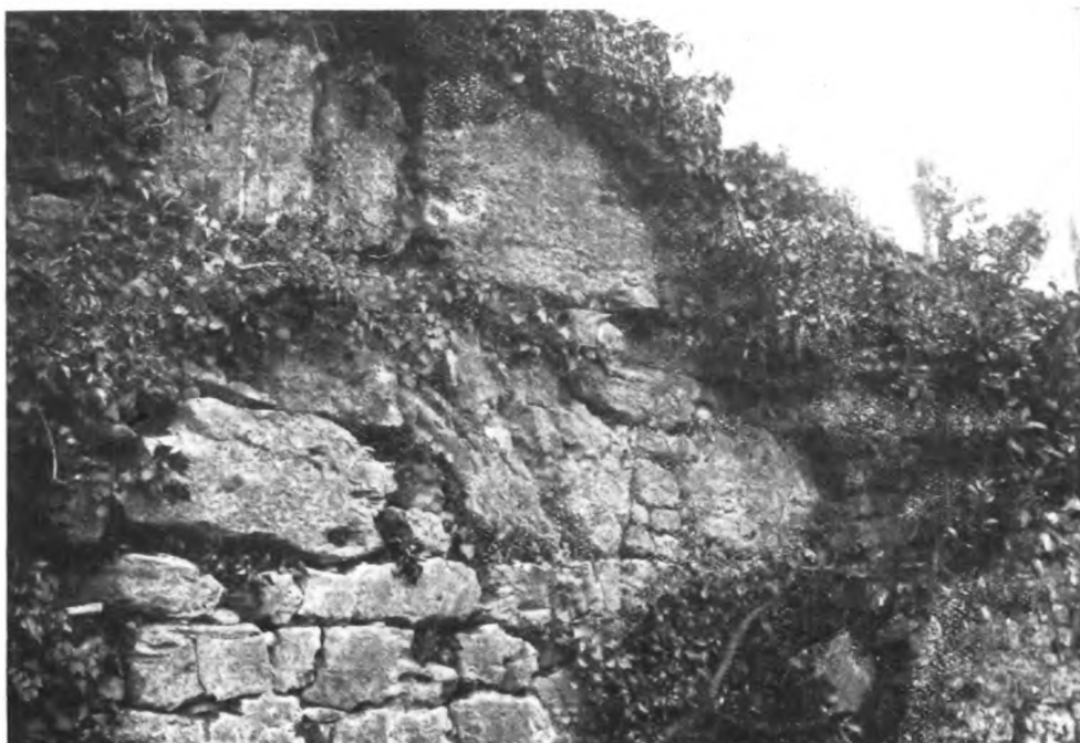
Fig. 1 - Residui della cinta etrusca dell'acropoli di Volterra, nel giardino Inghirami.
