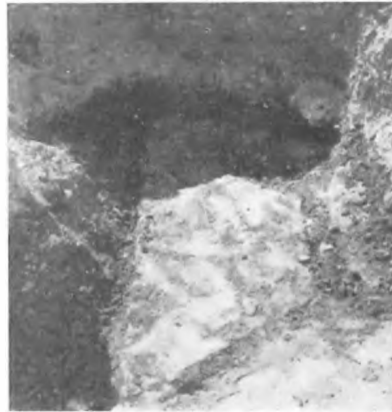
Palastreto di Sesto Fiorentino, Poggio del Giro: Continuazione del muro.
