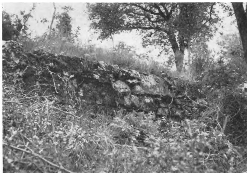
fig. 2. - Cetamura - Resti della cinta muraria, lato nord.
