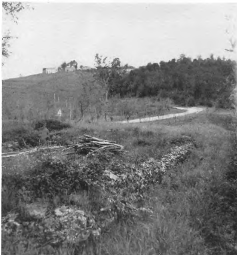
fig. 5. - Resti di fabbricati di calcestruzzo di tipo romano nel podere I Pianacci quasi alla sorgente dell'Ombrone. In alto l'abitato di Campi.
