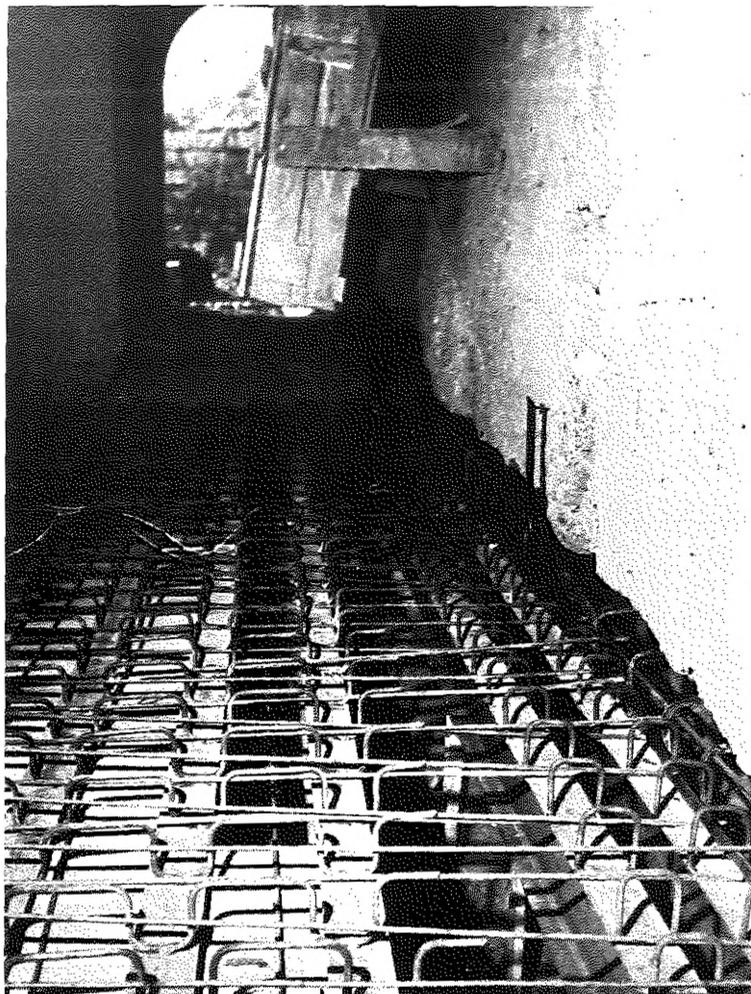
*a) Piano superiore: struttura in ferro per la realizzazione della soletta in cemento armato.*
