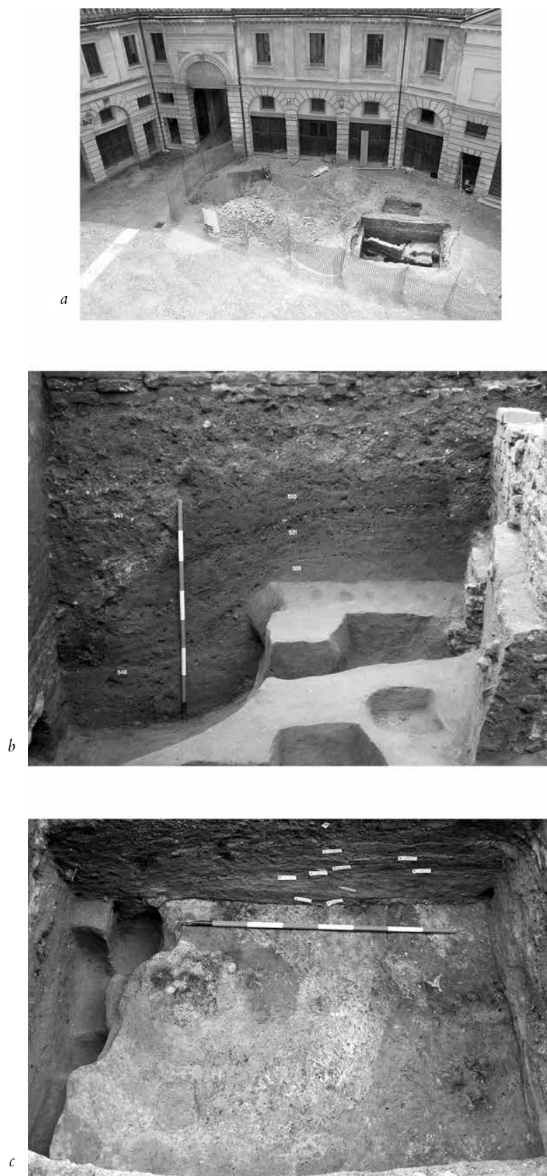
fig. 4 - Mantova. a) Il cantiere aperto in piazza Santa Barbara; b) Piazza Santa Barbara. Sezione; c) Piazza Santa Barbara. Piano pavimentale con presenza di focolari.
