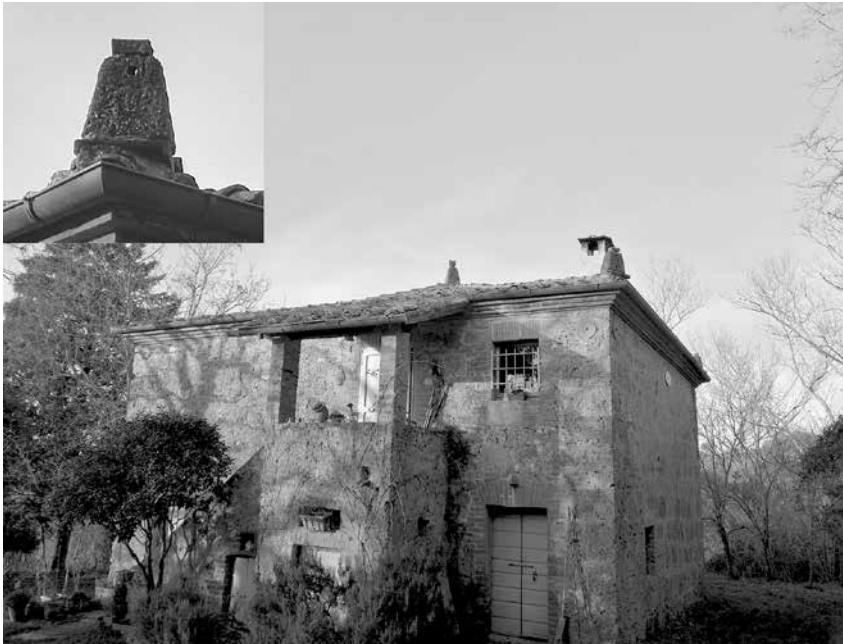
fig. 8 - Podere Palazzuolo, elementi in travertino di reimpiego sul tetto.
